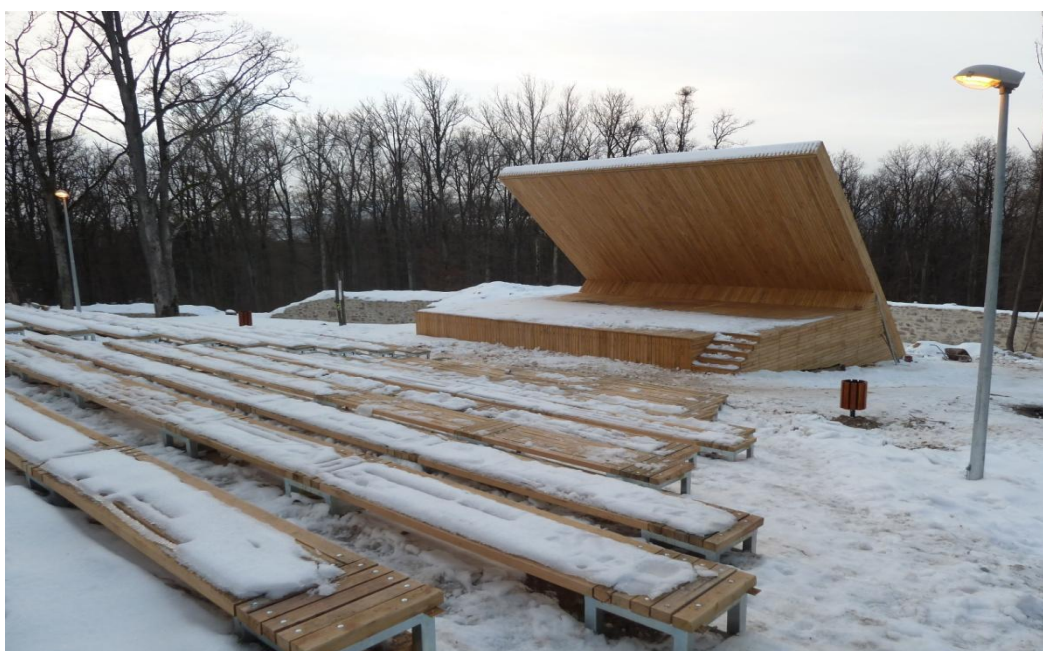
Novovybudovaný hradný amfiteáter
