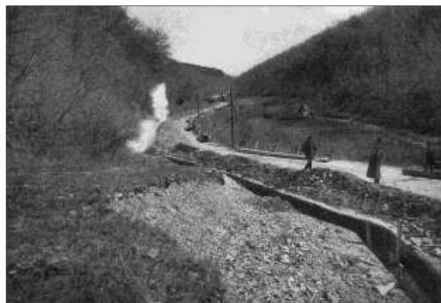
Kladenie potrubia košického vodovodu v Čermeli v r. 1905
