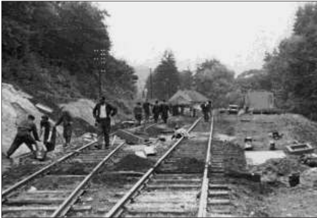
Výstavba trate Pionierskej železnice pri stanici Čermeľ v r. 1954
