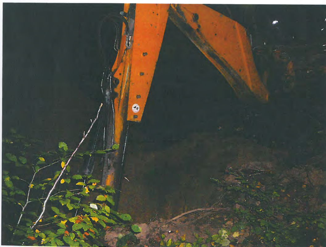
Obr.č.2 Kopaná ryha KS na lokalite Kamený potok – lokalita Krigrund s hlĺbkou 4,0 m
